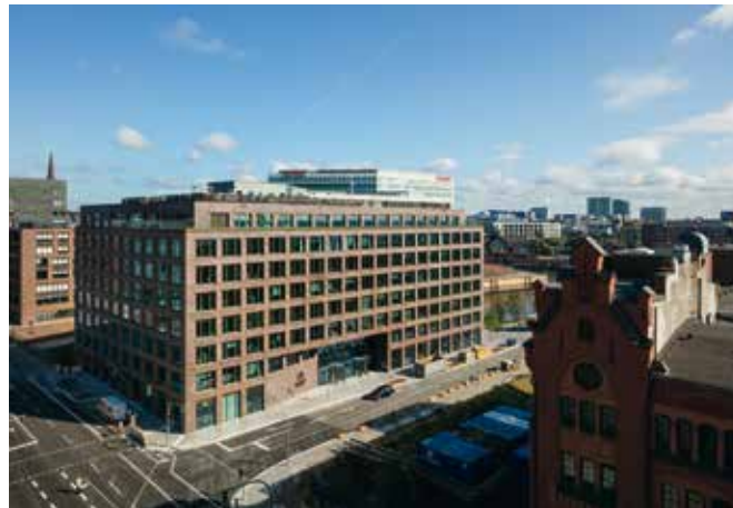
Blick auf die Südfassade: Der Haupteingang auf der Koreastraße ist geschosshoch verglast, aus der Mittelachse versetzt und asymmetrisch in das Gebäude eingeschnitten.
